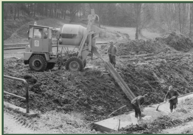
Izgradnja podužnih objekata za uređenje bujičnih vodotoka
