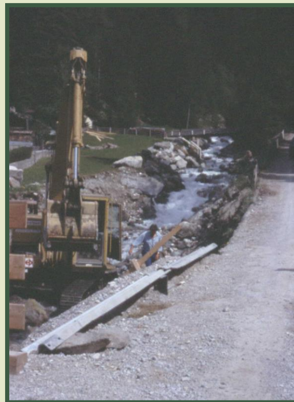
Izgradnja podužnih objekata za uređenje bujičnih vodotoka
