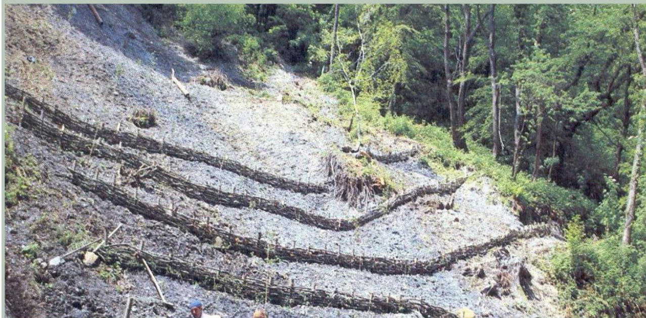
Sanacija erodirane padine pleterima
