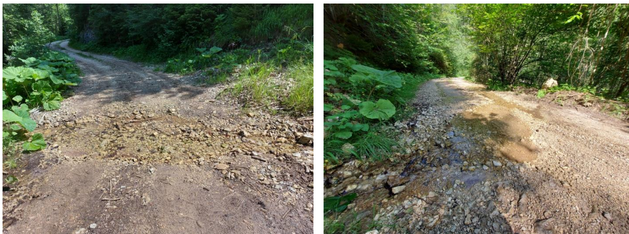
Slika 19: Primjer oštećenja puta na lokaciji gdje nedostaju vodopropusni objekti
