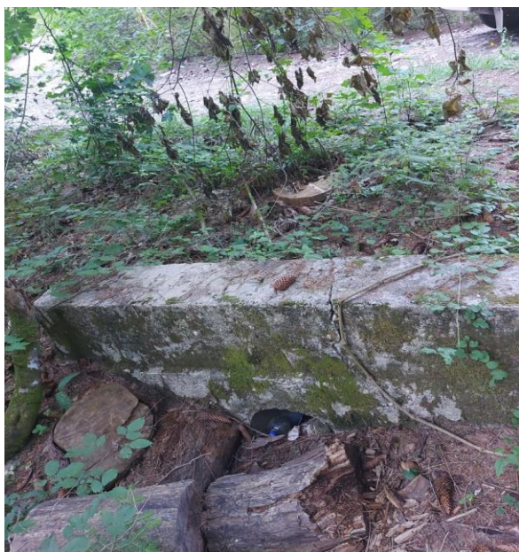
Slika 16: Primjer propusta koji je zatrpan i nije u funkciji (Čaluk, 2022)
