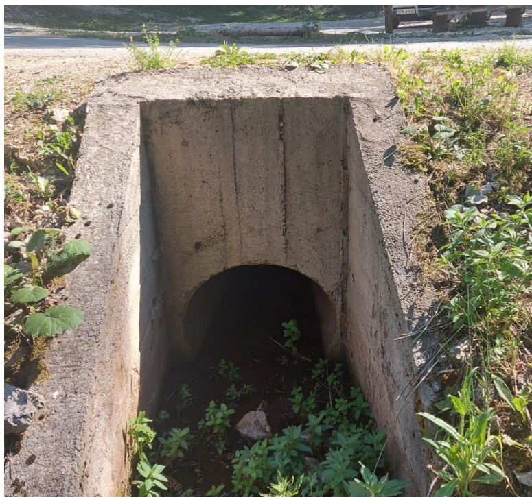
Slika 14: Propust Ø100 bez oštećenja s normalnom funkcionalnošću (Čaluk, 2022)
