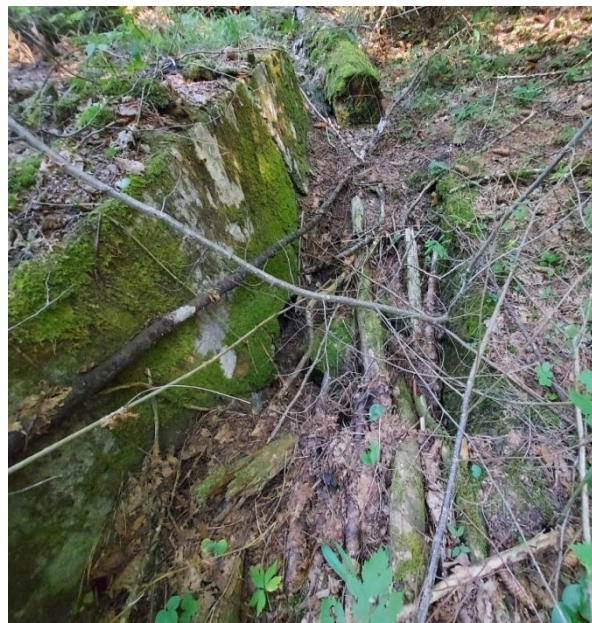
Slika 16: Primjer propusta koji je zatrpan i nije u funkciji (Čaluk, 2022)
