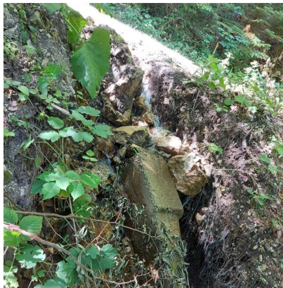
Slika 18: Primjeri oštećenja u neposrednoj blizini propusta (Čaluk, 2022)
