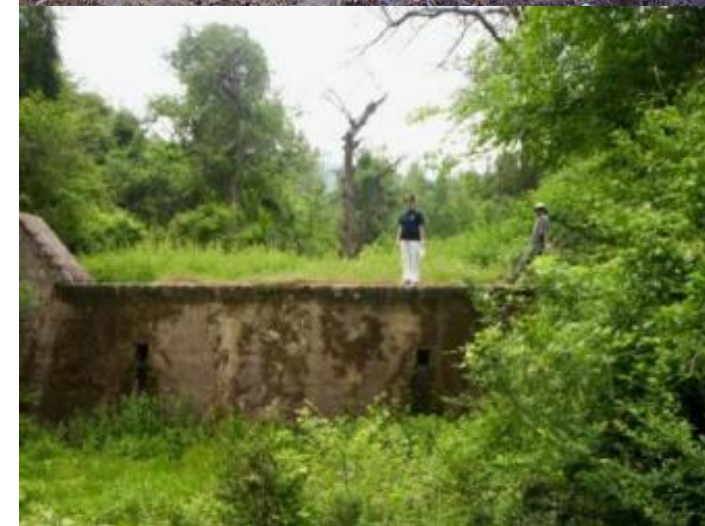
Regulacija i pregrada, Planina Vodno, krajem 50-tih, početkom 60-tih godina XX veka
