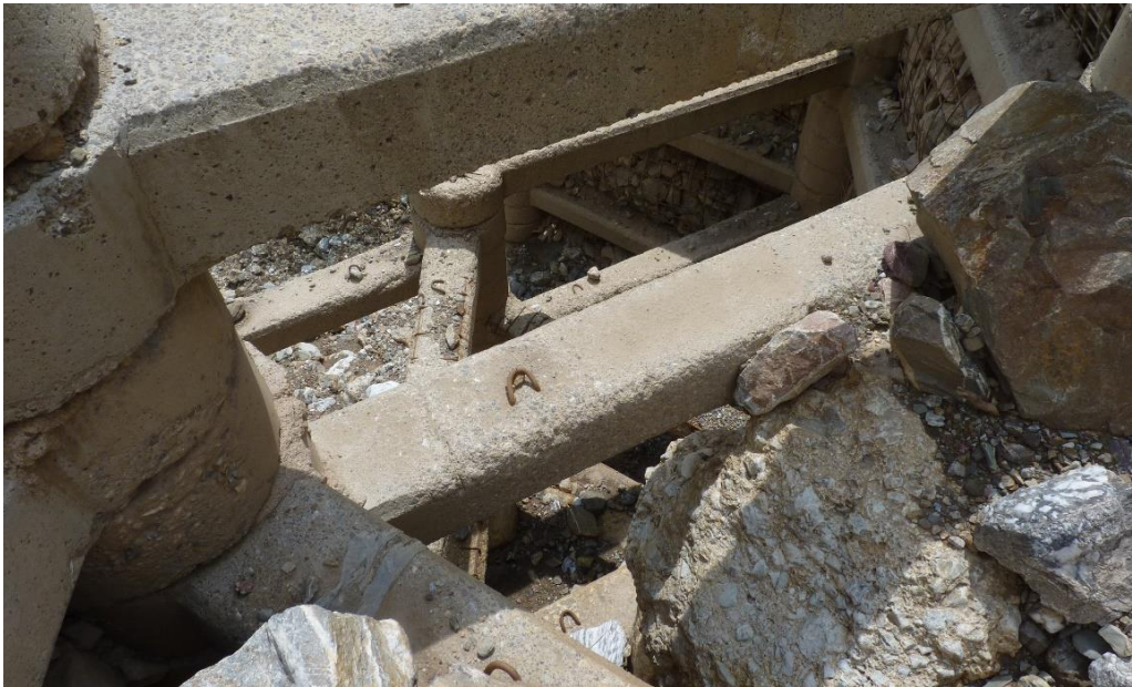
Сл. 22-25: Поглед на армирано-бетонски решеткасти прегради од типот „Херхеулидзе на порој „Авматица - С. Долно Косораста-Косоврашка бања)
