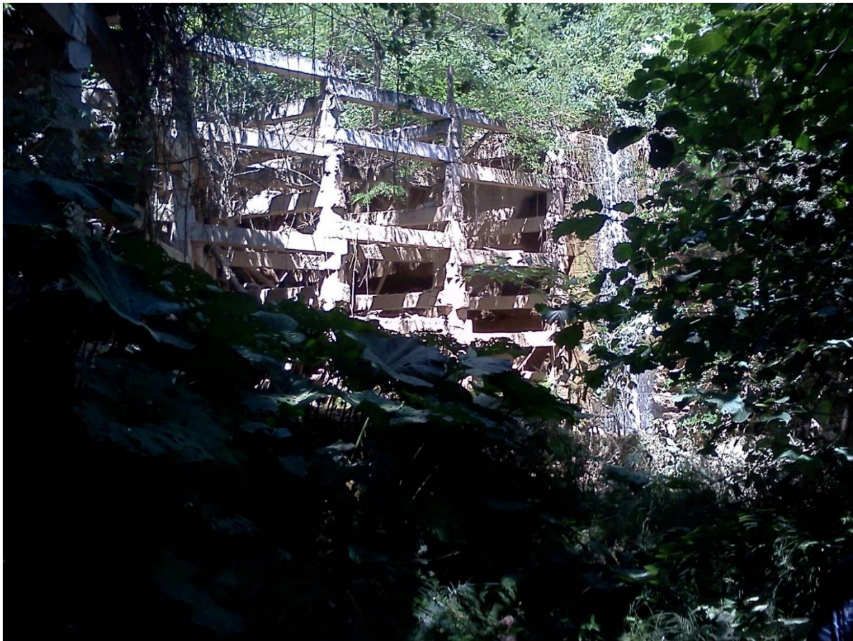
Сл. 18 и 19. Поглед на армирано-бетонската решеткаста преграда од типот „Херхеулидзе на Непроштенска Река (оштетување-поткопани стопи)
