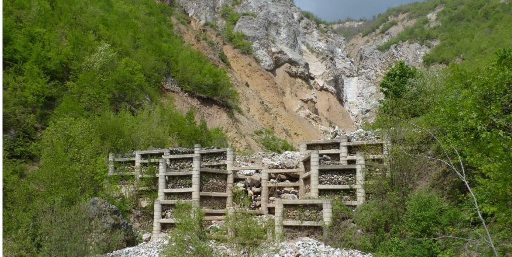
Сл. 22-25: Поглед на армирано-бетонски решеткасти прегради од типот „Херхеулидзе на порој „Авматица - С. Долно Косораста-Косоврашка бања)
