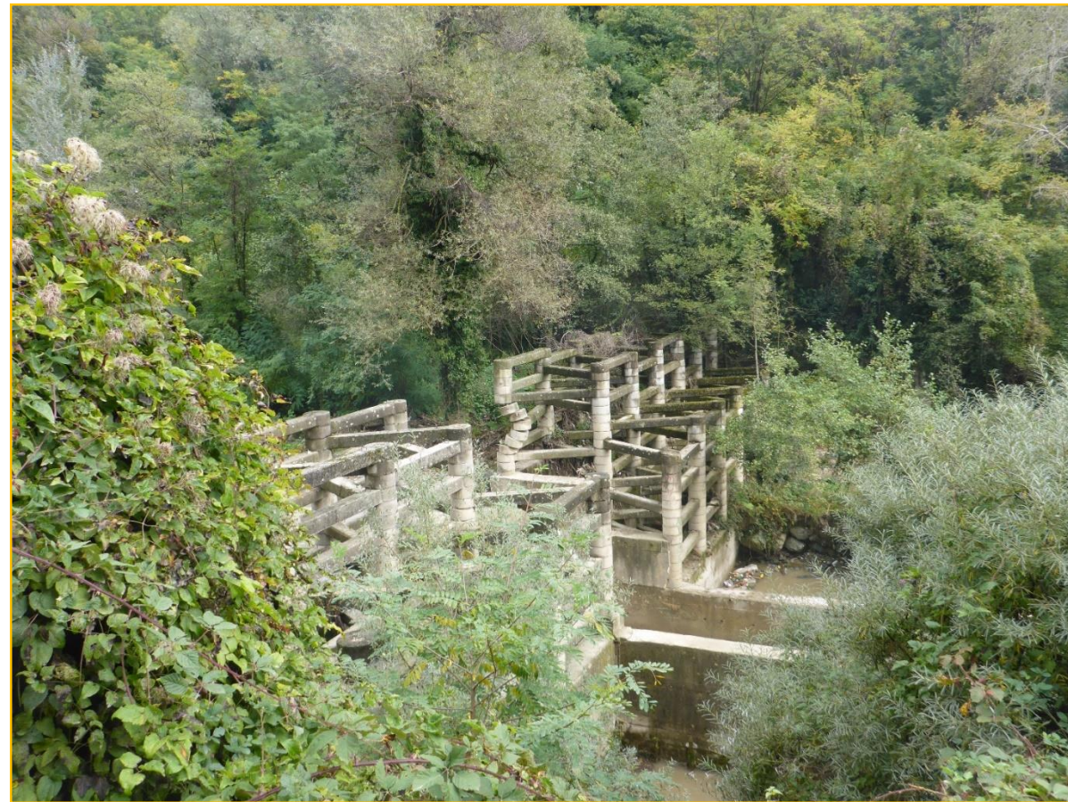
Сл. 14 и 15. Поглед на армирано-бетонската решеткаста преграда од типот „Херхеулидзе на р. Пена (преграда бр. 3, со минимални-мали оштетувања)
