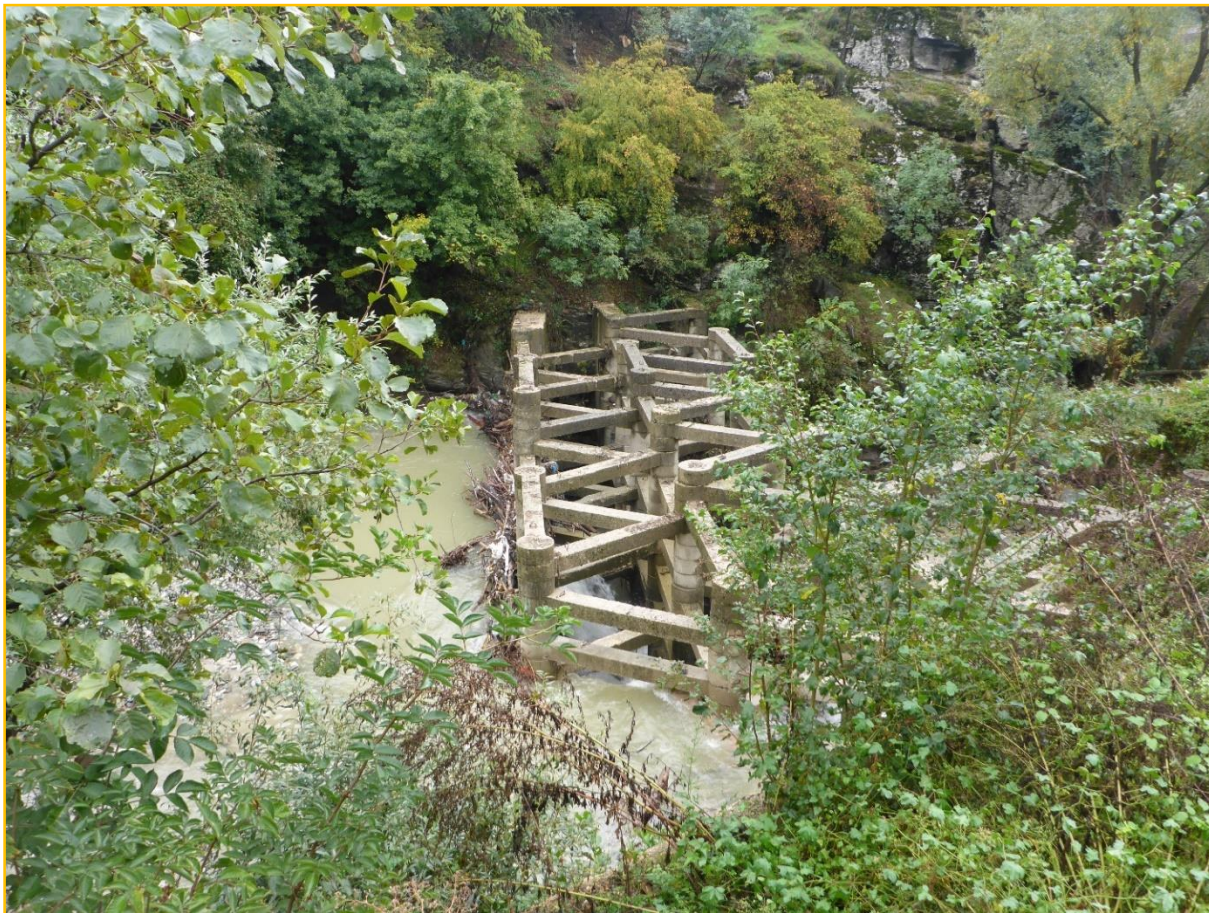
Сл. 10 и 11. Поглед на армирано-бетонската решеткаста преграда од типот „Херхеулидзе на р. Пена (преграда бр. 1, со минимални оштетувања)
