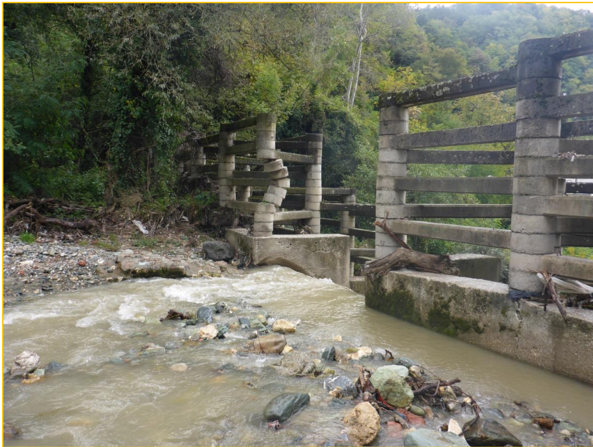
Сл. 14 и 15. Поглед на армирано-бетонската решеткаста преграда од типот „Херхеулидзе на р. Пена (преграда бр. 3, со минимални-мали оштетувања)
