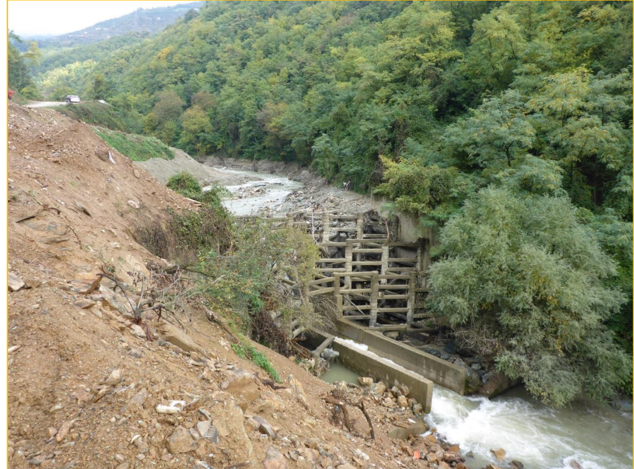
Сл. 12 и 13. Поглед на армирано-бетонската решеткаста преграда од типот „Херхеулидзе на р. Пена (преграда бр. 2, со минимални-мали оштетувања)
