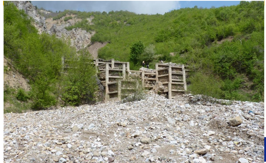
Сл. 22-25: Поглед на армирано-бетонски решеткасти прегради од типот „Херхеулидзе на порој „Авматица - С. Долно Косораста-Косоврашка бања)
