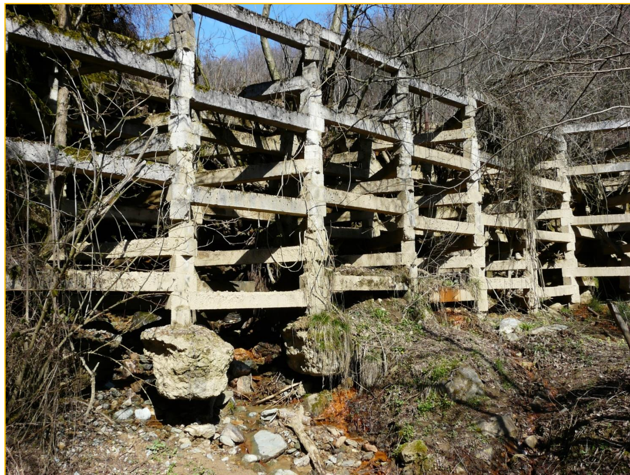
Сл. 20 и 21. Поглед на армирано-бетонската решеткаста преграда од типот „Херхеулидзе на Непроштенска Река (оштетување-поткопани стопи)
