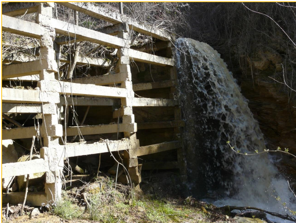
Сл. 20 и 21. Поглед на армирано-бетонската решеткаста преграда од типот „Херхеулидзе на Непроштенска Река (оштетување-поткопани стопи)
