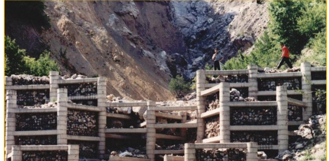
Сл. 22-25: Поглед на армирано-бетонски решеткасти прегради од типот „Херхеулидзе на порој „Авматица - С. Долно Косораста-Косоврашка бања)
