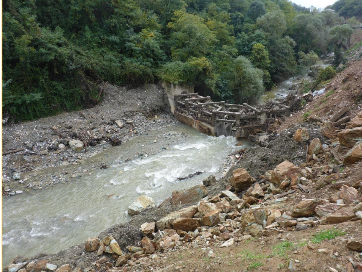
Сл. 12 и 13. Поглед на армирано-бетонската решеткаста преграда од типот „Херхеулидзе на р. Пена (преграда бр. 2, со минимални-мали оштетувања)
