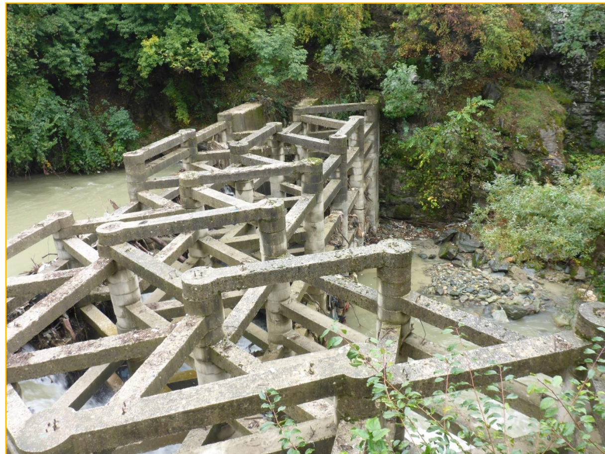
Сл. 10 и 11. Поглед на армирано-бетонската решеткаста преграда од типот „Херхеулидзе на р. Пена (преграда бр. 1, со минимални оштетувања)
