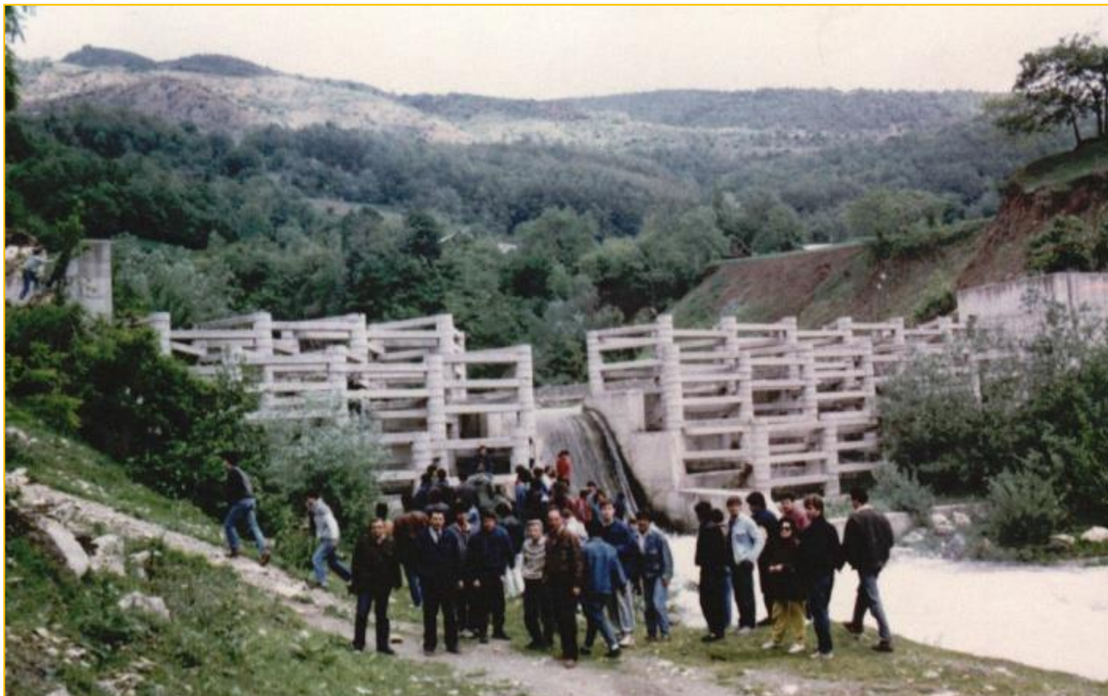
Сл.1. Посета на преставници ја ЈУФРО на изведени противерозивни и противпоројни работи и објекти во РМ (р. Пена, 1985)
