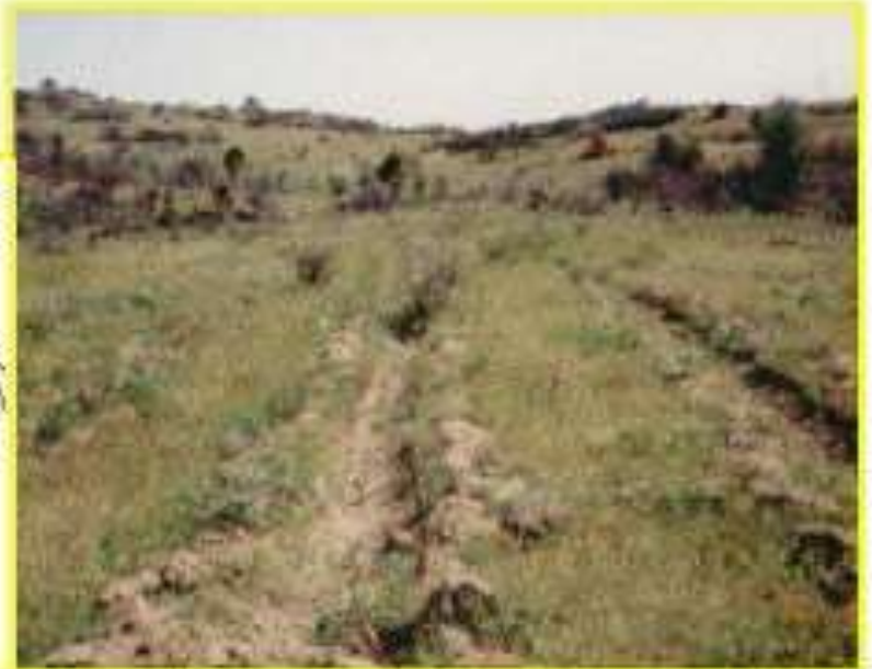
Слика 21: Дренажен ров за свлечишта, контуирен ров, контурни бразди отворени со рипер со странично крило
